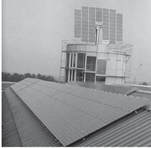
الشكل (1-10): منظومات فولتضوية ثابتة، ومولد فولتضوي 6.6 kW p بجهاز تعقب ثنائي المحور ((Offenburg), (Hans Grohe)).
