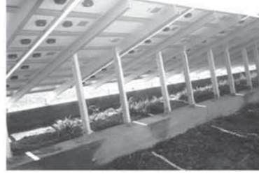
الشكل (18-2): إنشاء تقليدي من خرسانة إسمنتية وألمنيوم للقاعدة، وبنية الدعامة، والتركيب (مركز أبحاث الطاقة الكهربائية (CEPEL)، ريو دي جانييرو).
